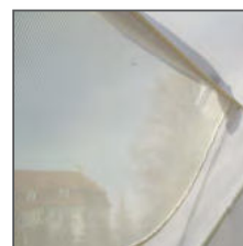
Okna zabezpieczone siatką
