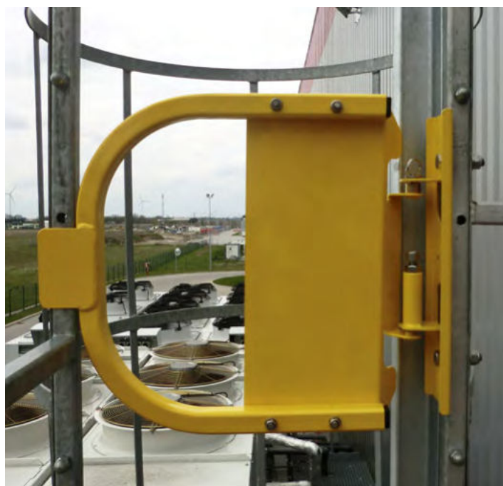
Mocowanie bramki AT 241 do słupków wsporczych AT 241 003
